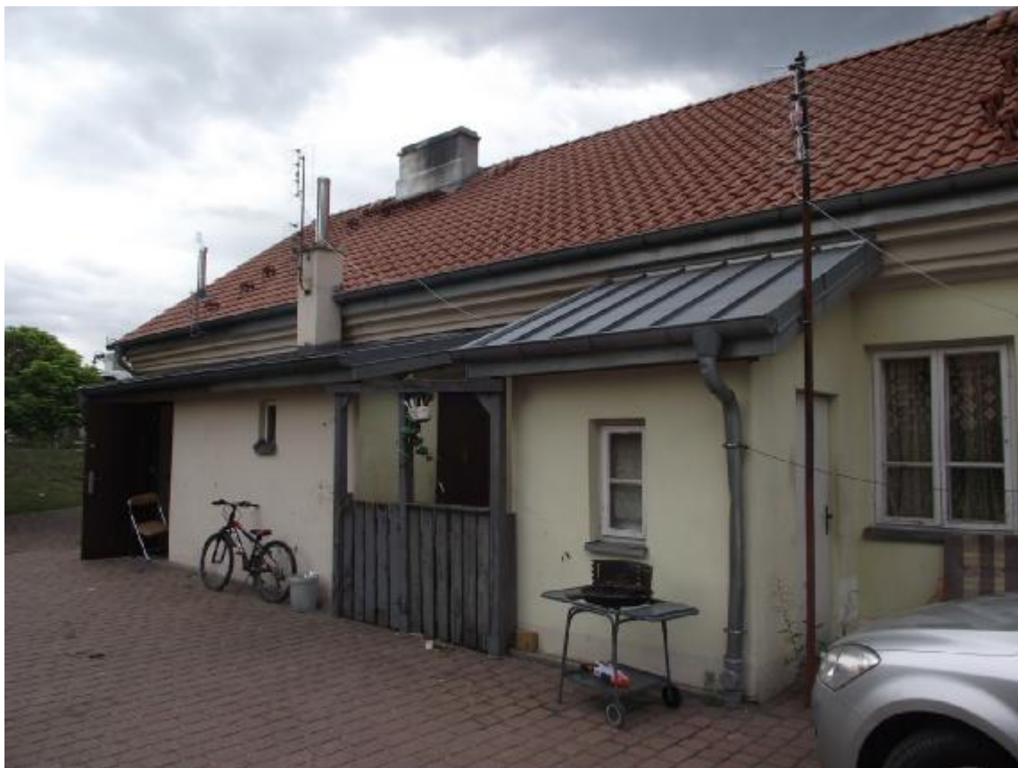
Fot.2. Fragment elewacji południowej
