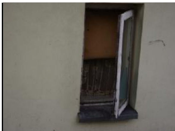
Fot.5. Wybrane uszkodzenia kominów, orynnowania i okien
