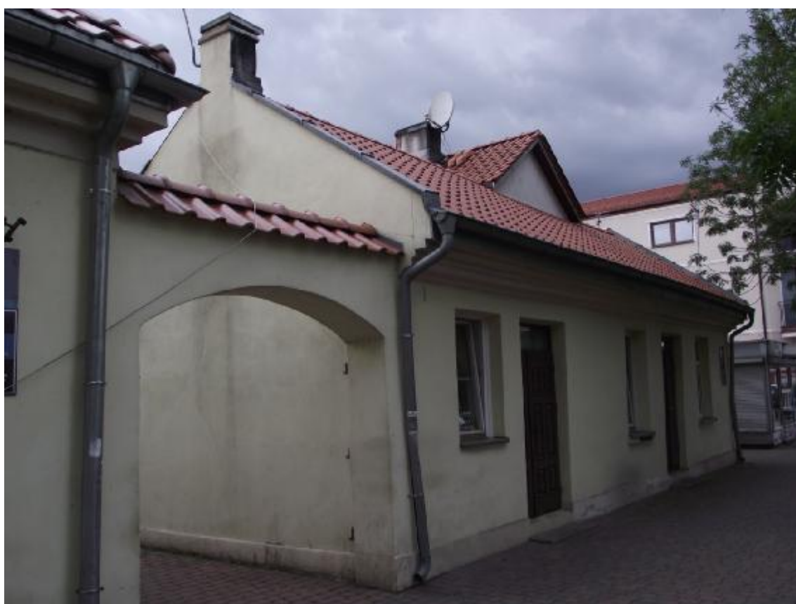
Fot.3. Widok elewacji wschodniej od ul. Pułtuskiej
