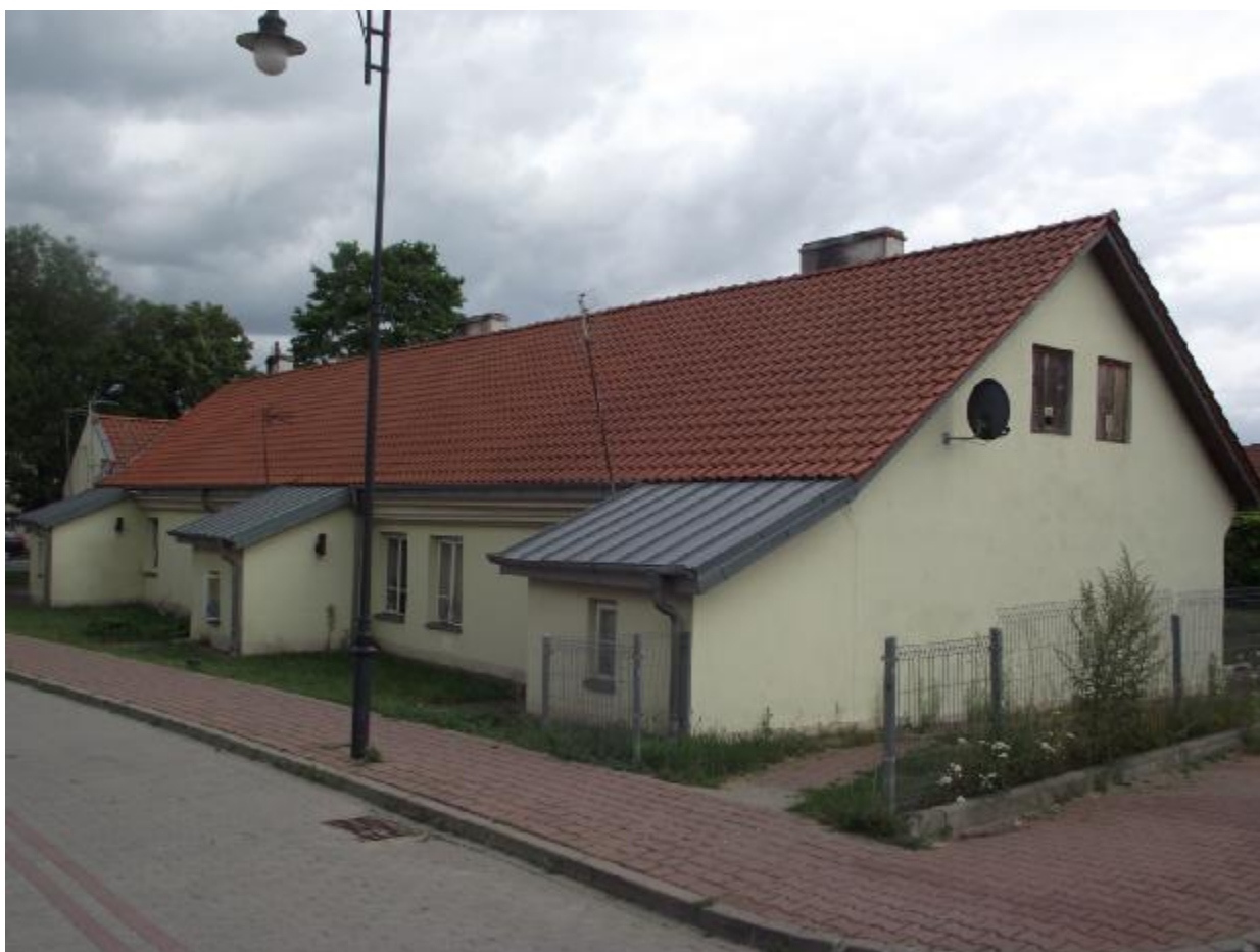
Fot.1. Elewacja północna i zachodnia – widok od strony drogi wewnętrznej
