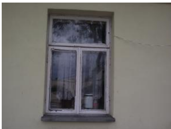
Fot.6. Istniejąca stolarka okienna (drewniana i PCW)
