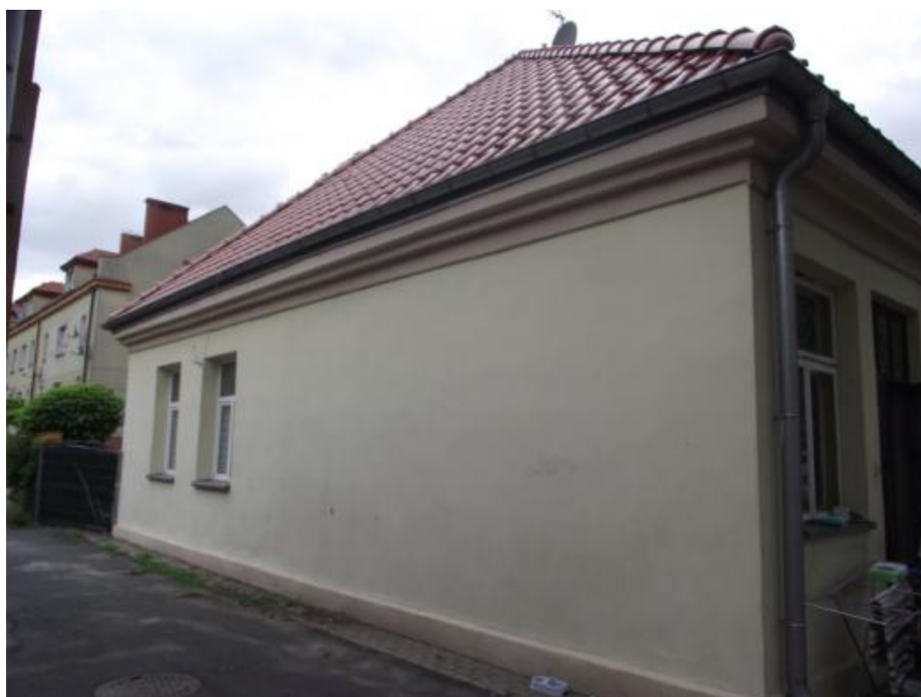
Fot.3. Widok elewacji południowej
