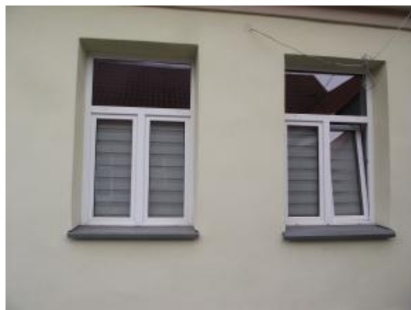
Fot.6. Istniejąca stolarka okienna (drewniana i PCW)
