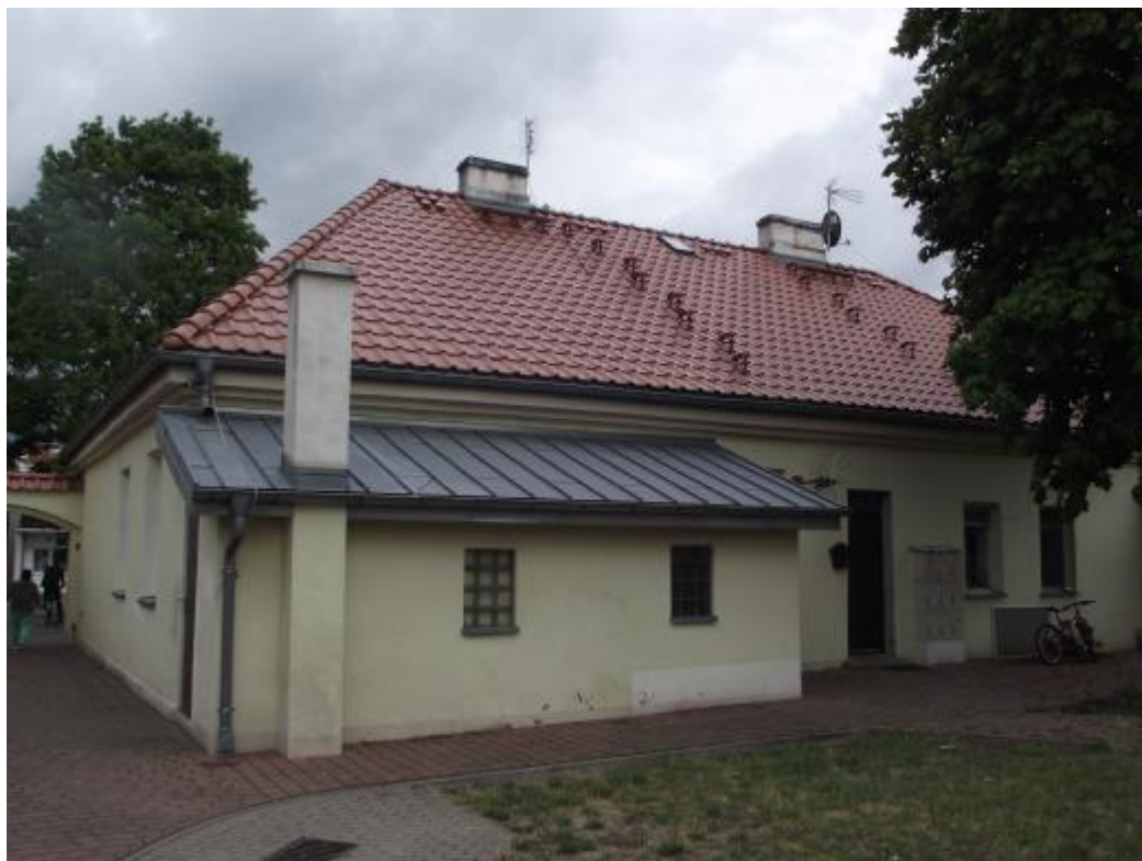
Fot.4. Fragment elewacji wschodniej
