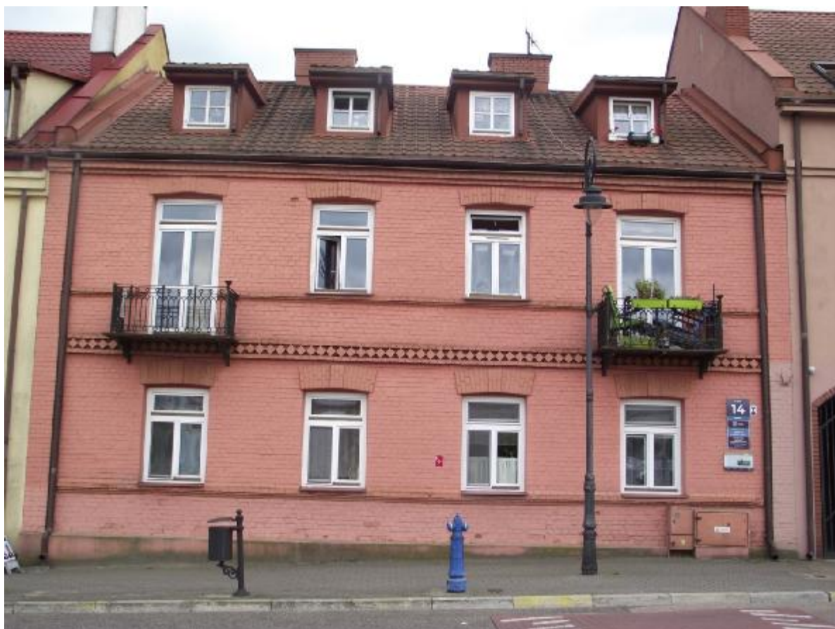
Fot.1. Elewacja północna od strony ulicy Rynek
