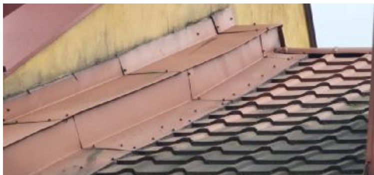
Fot.4. Obróbki blacharskie i pokrycie dachu
